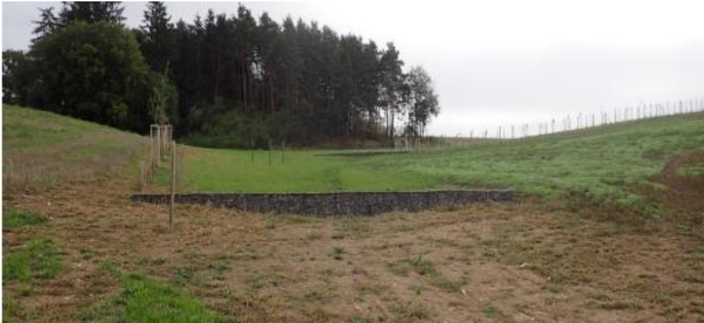
Obr. 18: Ukázka gabionové přehrážky ve stabilizované dráze soustředěného odtoku (zdroj: VÚV TGM, v.v.i.)
