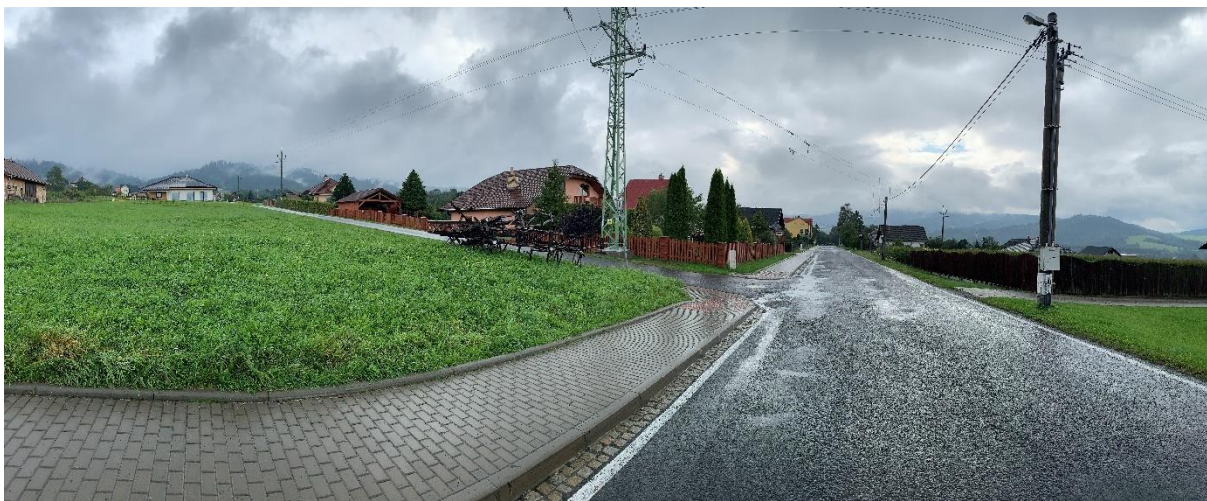
FOTO 3 – Panoramatický pohled na silnici III/01150, která tvoří bariéru pro povrchový odtok při větších srážkách
