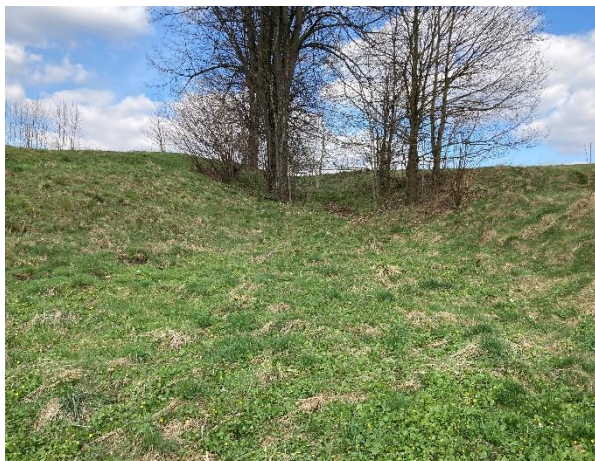
FOTO 23 – DSO nad vtokovým objektem, místo pro navržené přehrážky v povodí PB5
