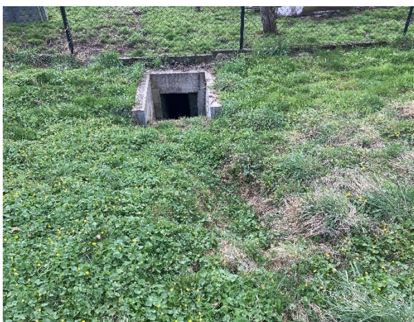
FOTO 22 – Vtokový objekt nad zástavbou místní části Žihla
