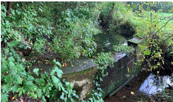
FOTO 6 – Pohled na nekapacitní příkop podél levé strany silnice a průnik DSO se zástavbou v dílčím povodí č. 3
