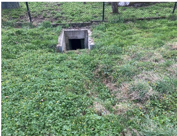
FOTO 22 – Vtokový objekt nad zástavbou místní části Žihla
