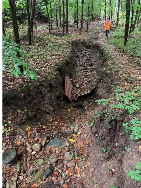
FOTO 11 – Vymleté koryto v Městském lese pod závěrným profilem vymezeného dílčího povodí č. 3
